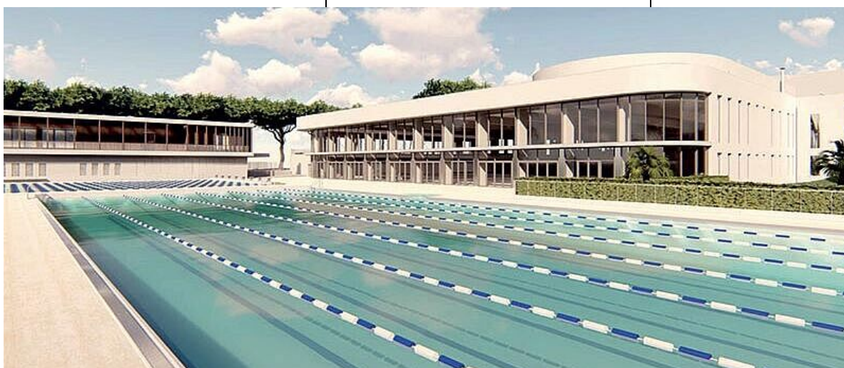
Lignes d'eau des bassins extérieurs
