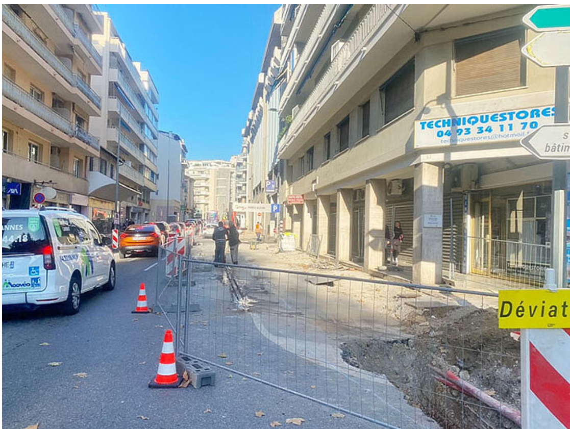
Perspective des travaux
