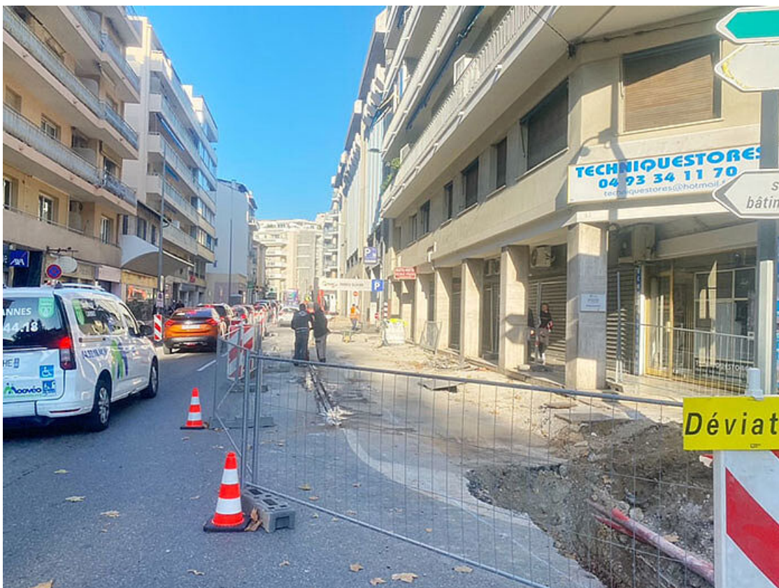
Perspective des travaux
