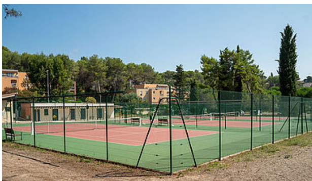
Les courts de tennis du Stade des Semboules
